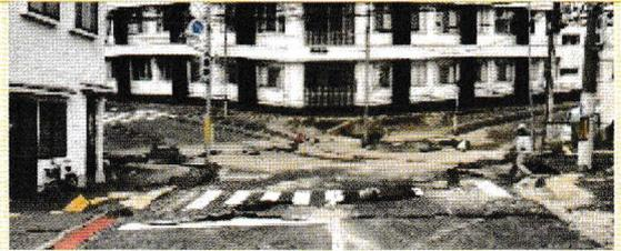
9月26日、広島市西区で、地下35mに雨水をためる直径約5mの雨水管を設置するシールドトンネル工事の現場直上の道路が陥没(30m×40m×最大深さ2m)、周辺12棟に傾くなどの被害がでて、居住者が避難生活を送っています。トンネルに出水してから10分程度で地表陥没の重大事故。被害拡大防止のためにトンネル内部を水没。検討委員会を設置して原因調査を行うとのこと。
