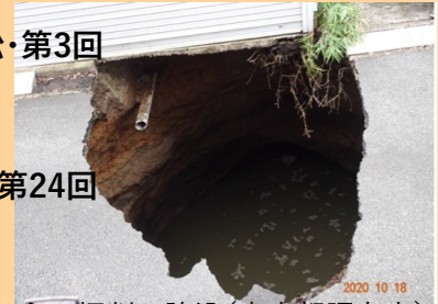
外環道トンネル掘削で陥没(東京都調布市)
