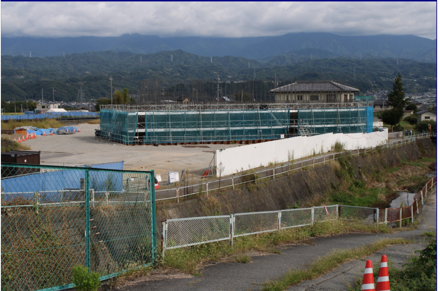
土曾川橋りょう P1橋脚のケーソン
